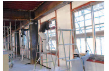
窓枠の取り付け作業も着々と進んでいます
