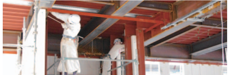
各現場を見ながら、様々な耐震性強化のための構造などについて説明していただきました
